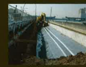
護岸整備の防根
