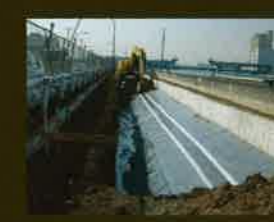
護岸整備の防根
