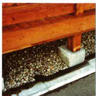
ウッドデッキ下
